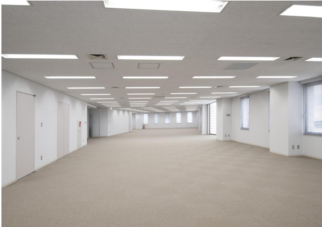
原状回復工事後の4階（平成31年3月）
