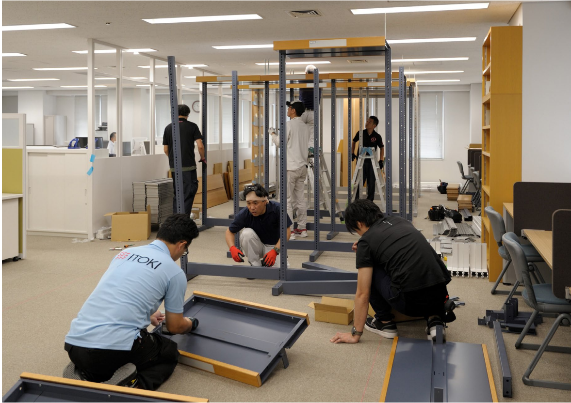
閲覧室の4階への移転工事（洋書コーナー）
